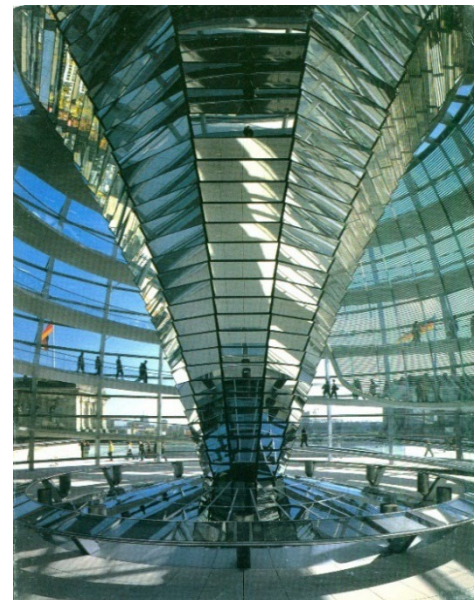
Figura 19. Vista interior de la cúpula, embudo de espejos que reconducen la luz natural al interior del edificio.
