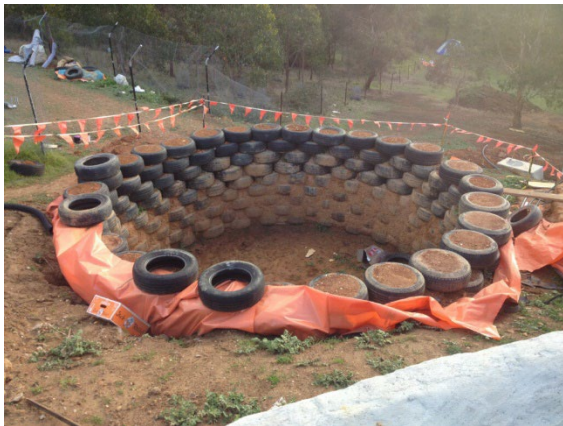
Figura 7. Paredes de carga con neumáticos rellenos de tierra compactada
