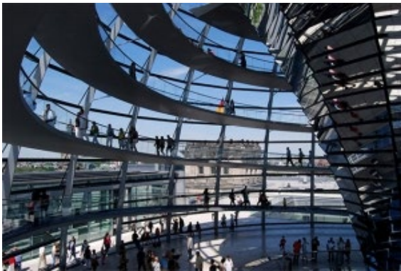
Figura 17. Interior de la cúpula. Vista de las rampas helicoidales que hacen el recorrido junto al cerramiento de cristal.
