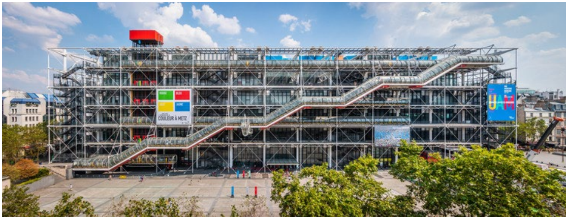
Figura 24. Centro Pompidou (París, Francia): Un Icono de la Arquitectura High-Tech.
