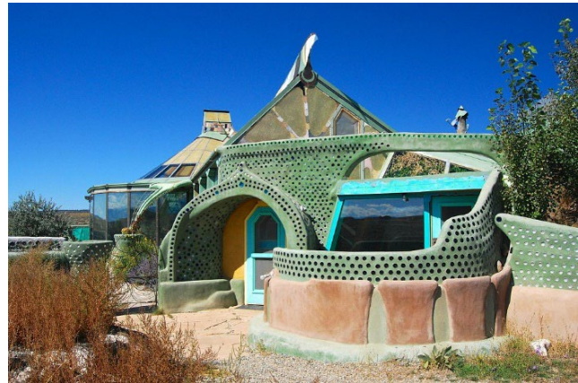
Figura 8. Exterior vivienda construida terreno vegetal
