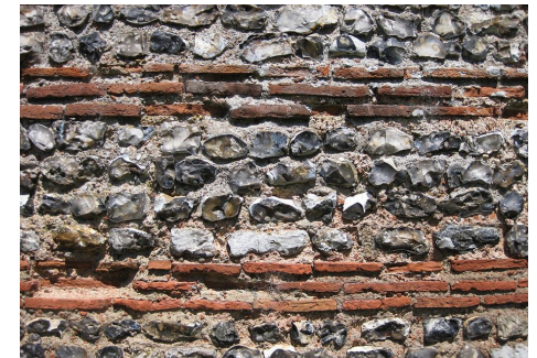
Ladrillo en muro de fortaleza
