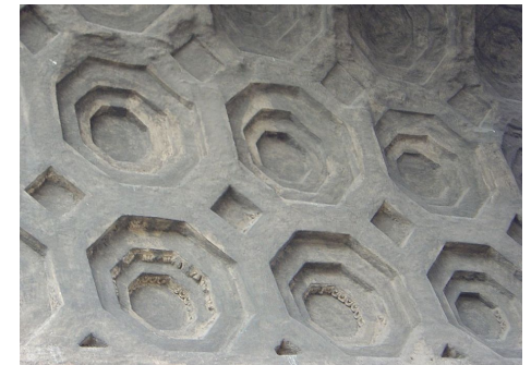
Cúpula en hormigón
